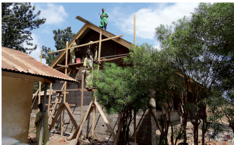
Das neue Jungenschlafhaus im VTC kurz vor der Fertigstellung
