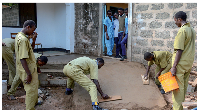
Schüler beim Bau eines behindertengerechten Zugangs zu den neuen Unterrichtsräumen
