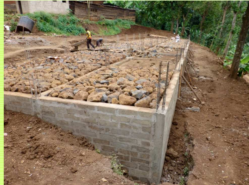
Neubau Jungenschlafräume Kishumundu
